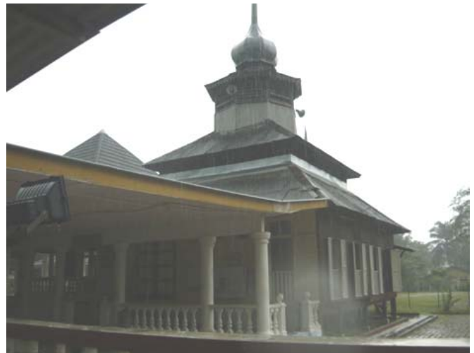
Gambar foto (2): Masjid Lama Kg. Mendun, Negeri Sembilan yang berusia hampir 100 tahun masih berdiri dengan binaan tambahan struktur yang boleh dibezakan dengan yang asal. Masjid ini dikatakan dibina pada tahun 1928 yang diasaskan oleh Tuan Hj Mohd Said B.Patun, salah seorang penduduk tetap dan ulama di kampung tersebut.
