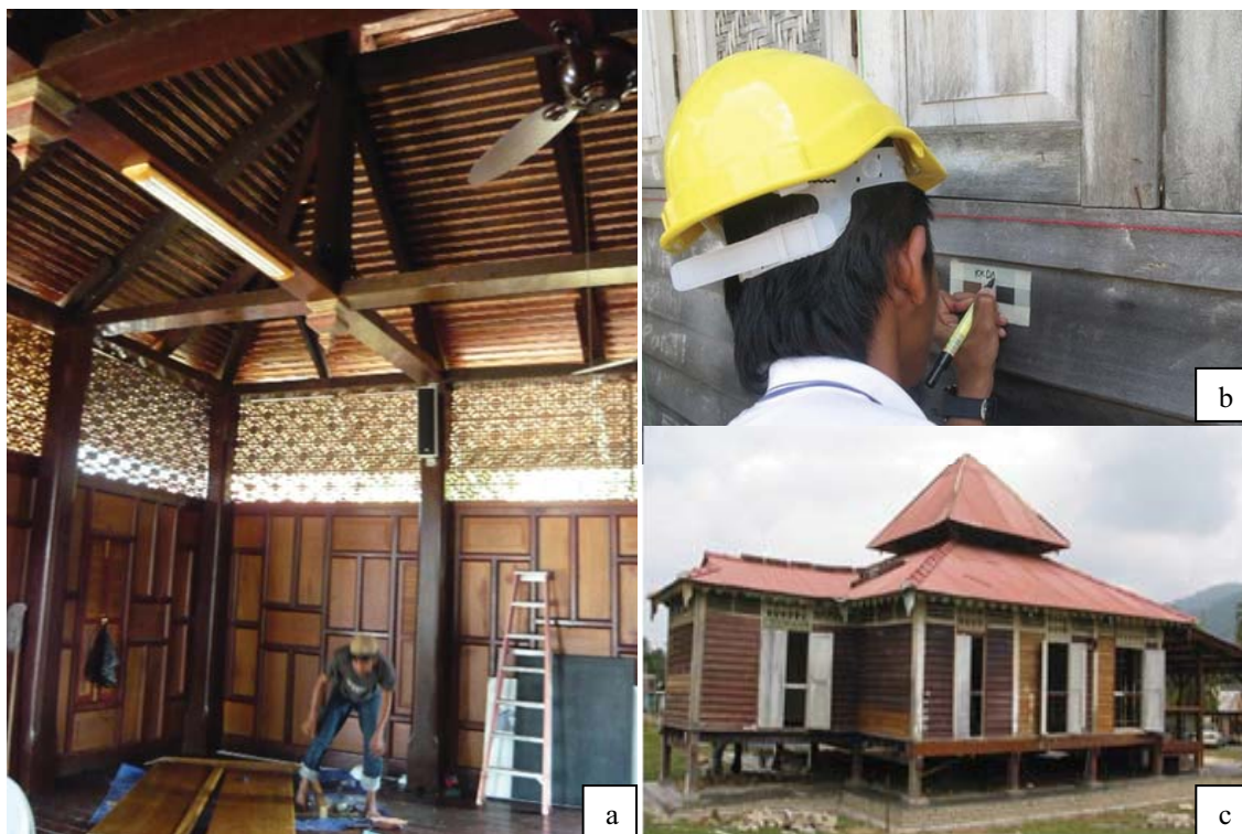
Gambar foto 3: Kerja-kerja pembaikan dan pemuliharaan masjid kayu, (a) Kerja-kerja kemas dalam pembaikan Masjid Lama Mulong, Kelantan (b) Proses kerja mengenal pasti warna cat asal, (c) Pembaikan Masjid Lama Kg. Jerang yang hampir siap (Johar, 2012)
