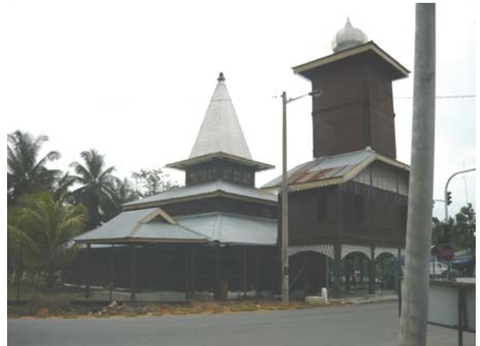
Gambar foto (1): Masjid Tinggi Lama Bagan Serai dibina pada 1897, dan telah menjalani kerja pemuliharaan bangunan.
