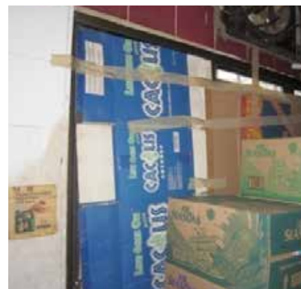
Foto 1.6: Keadaan pintu yang sukar dibuka dan elemen pintu yang sudah using dan berkarat
