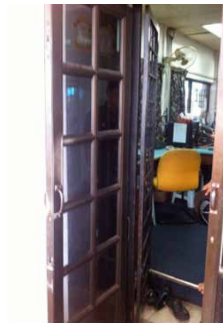
Foto 1.6: Keadaan pintu yang sukar dibuka dan elemen pintu yang sudah using dan berkarat
